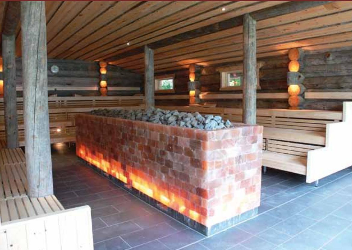
Der gasbefeuerte Saunaofen erbringt eine starke Leistung von 150 kW. Er ist ummauert mit hinterleuchteten Salzsteinen, so dass er von unten zu glühen scheint. Ein Steinkorb mit 500 kg schwerem Perioditgestein lässt die aromatischen Aufgüsse effektiv zischen. Mit den Lichtwirkung in der Raummitte korrespondieren die Keloleduchten an den Außenwänden. Sie unterstreichen die stimmungs-volle Atmosphäre in dem Saunaraum, der rund acht mal zwölf Meter misst.
